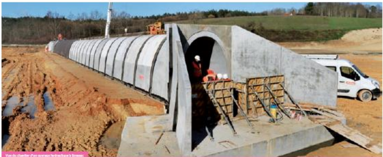
Vue du chantier d'un ouvrage hydraulique à Brosses.
