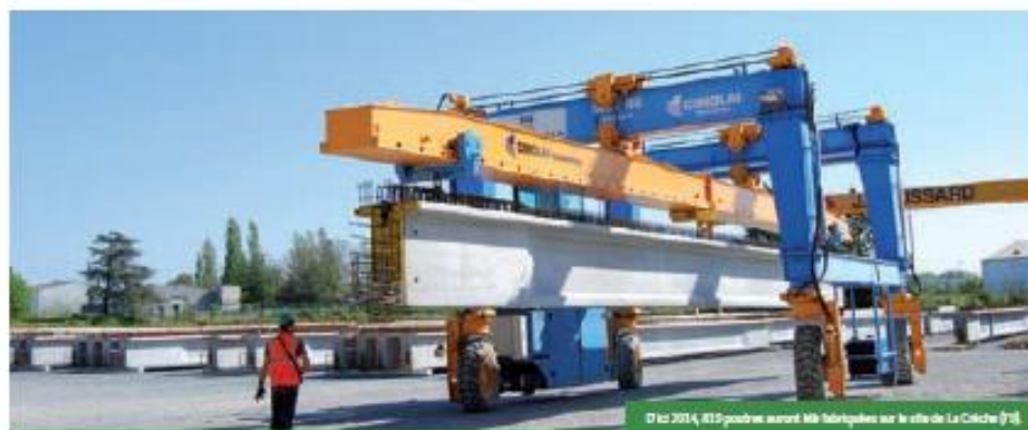
D'ici 2014, 415 poutres auront été fabriquées sur le site de La Crèche (76)
