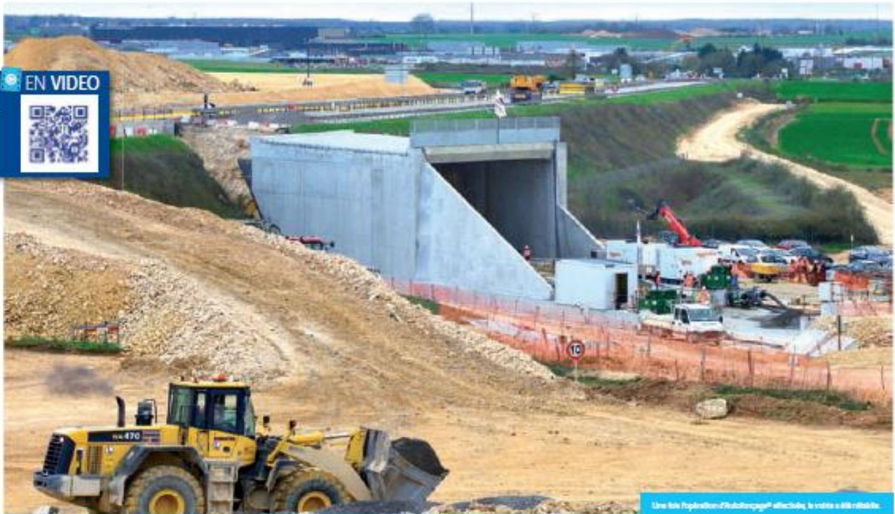
Une fois l'opération d'autofonçage effectuée, la route a été réouverte.
