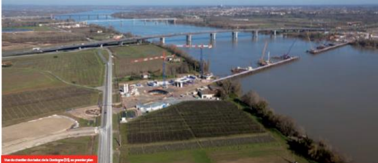
Vue du chantier du tracé de la Dordogne (D5) en perspective
