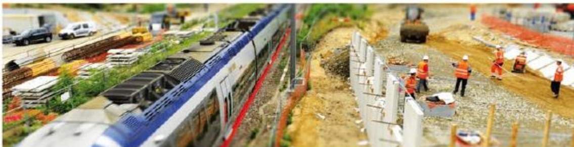
Construction d'un pont-routier, le nouveau pont Bercy au sein du quartier de la Gironde à Ambarès-et-Lagrave (27).
