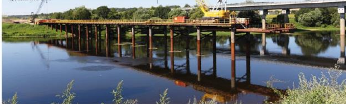
Le viaduc de la Vienne, entre Pont-de-Piles et Noublin, est l'un des 23 ouvrages qui seront réalisés pour réaliser la ligne à grande vitesse.
