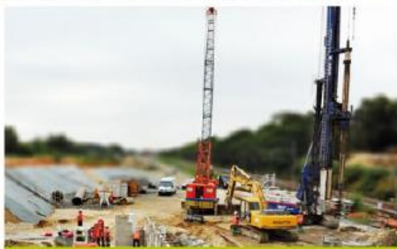
Les deux derniers appuis du futur pont Bercy sont forés dans le sol. Travaux vers achèvement fin d'année 2012.
