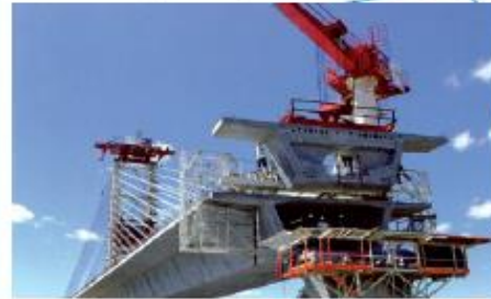
Les voussoirs sont des piliers de béton, en forme de pyramide tronquée. Mis bout à bout, ils forment l'arcade d'un pont ou d'un viaduc.
