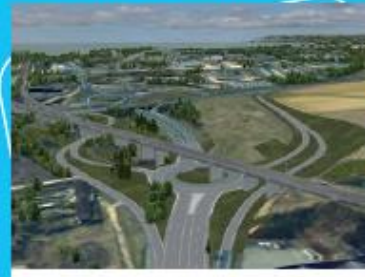
Vue 3D des aménagements qui seront réalisés à La Folle (80). Depuis l'entrée, des travaux préparatoires à l'installation d'une base chantier sont en cours le long de la RD910 (route de Paris).
