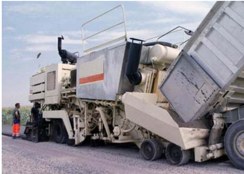
Mise en œuvre de grave émulsion au malaxeur finisseur (USIRF)
